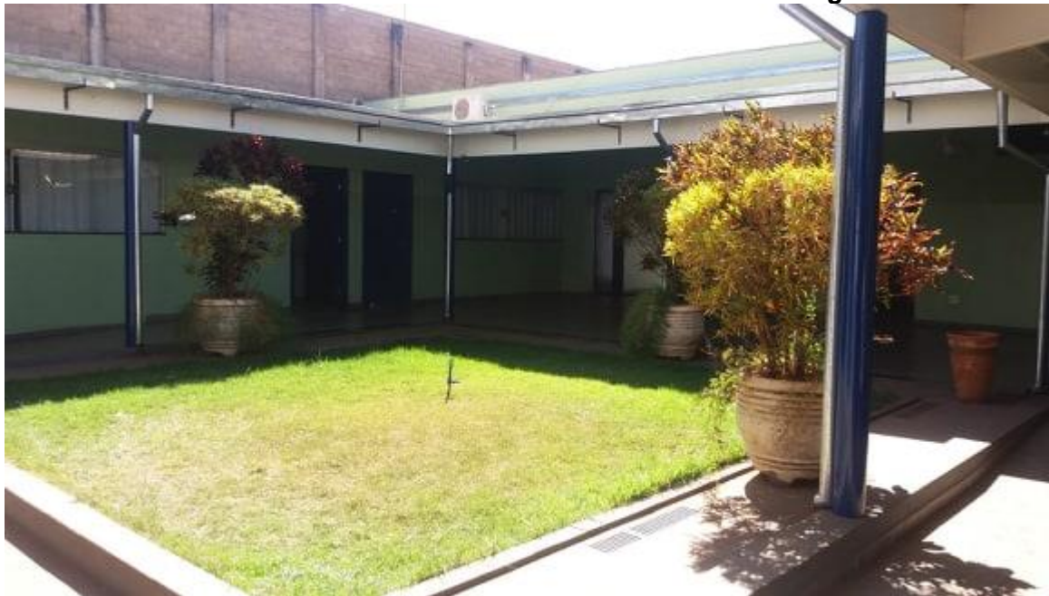
Pintura – corredores e pátios internos (acesso a salas de atividades)
