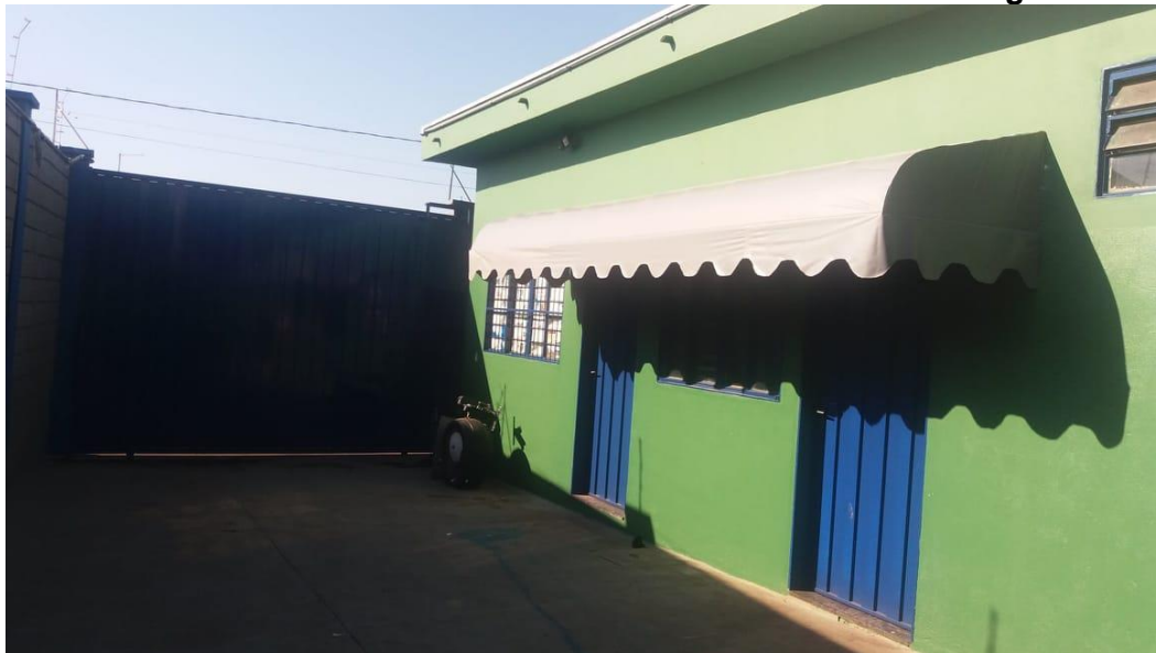
Pintura – corredor de acesso as salas de atividades e estacionamento interno (recebimento de mercadorias).
