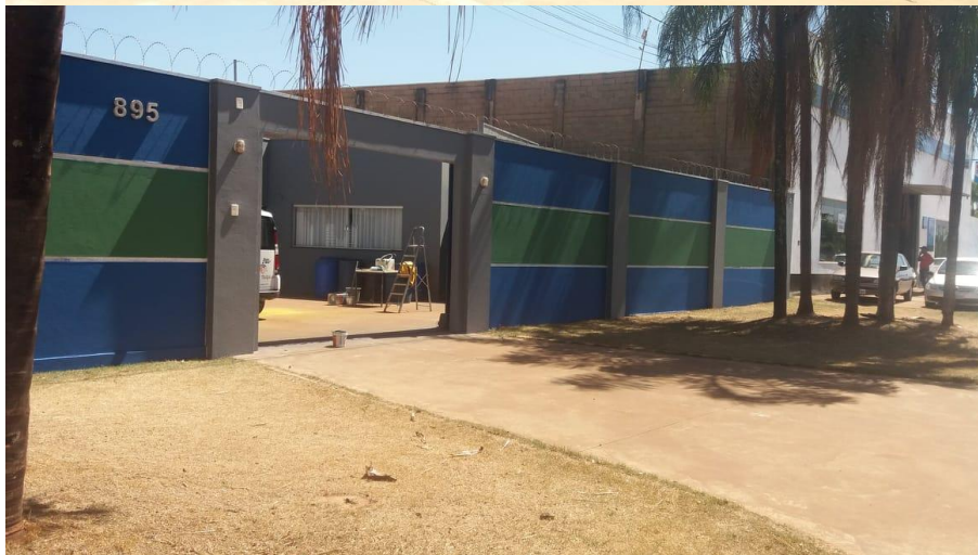
Pintura –fachada da Instituição.
