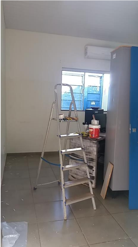
Pintura e iluminação – Sala de planejamento. Pintura e iluminação – Sala do Serviço Social.
