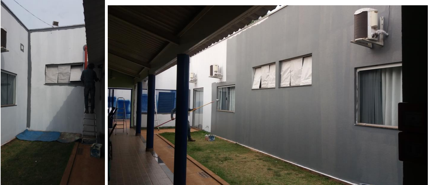
Pintura corredores de acesso as salas de atividades e estacionamento privativo.
