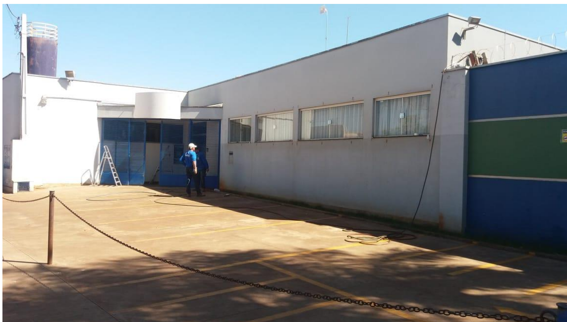
Pintura –fachada da Instituição.
