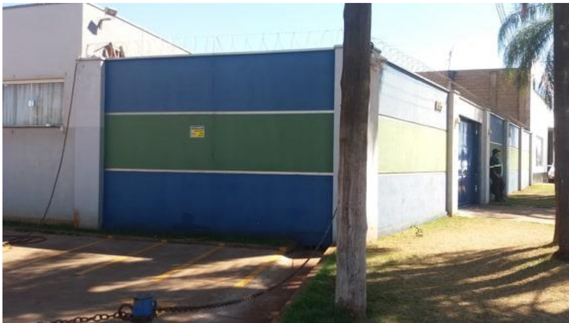
Pintura –fachada da Instituição.
