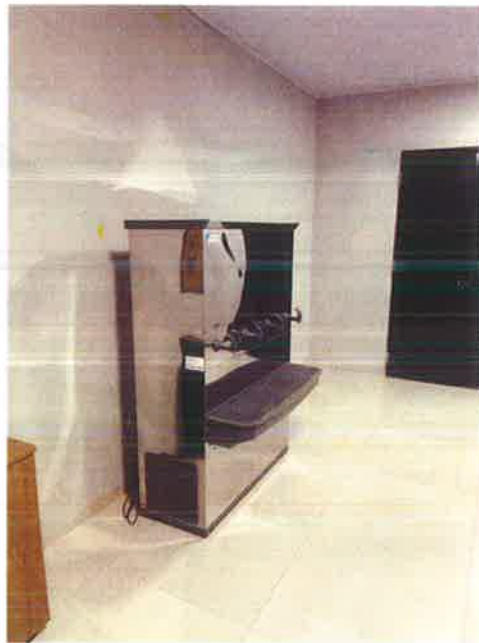
Fornecimento e instalação de filtro de água de 4 vias
