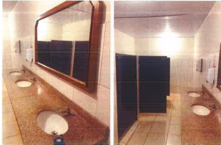
Banho 02 Feminino – Reforma completa com alteração de layout
