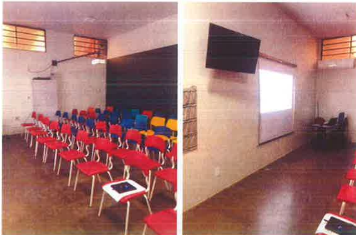
Sala de Psicologia – Instalação/execução de piso sobre piso existente
