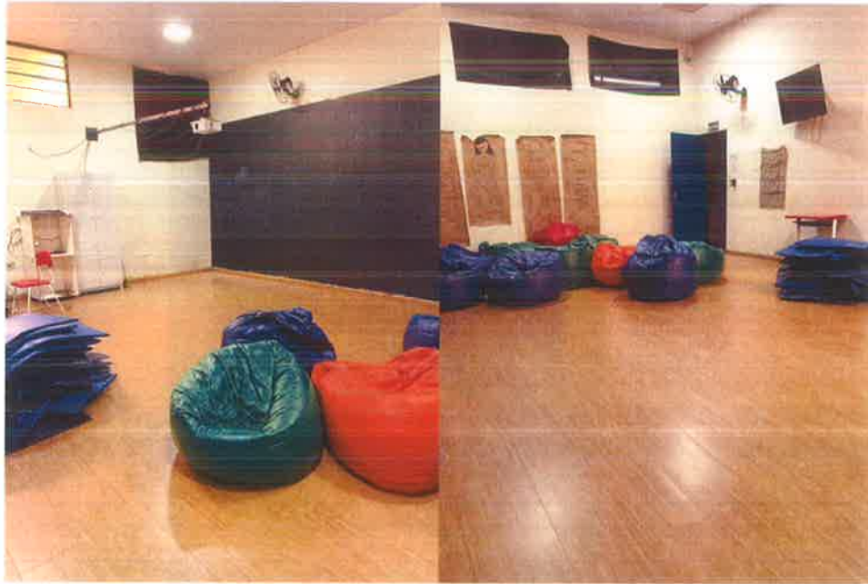
Sala de Formação 01 e Sala de Psicologia – Instalação/execução de piso sobre piso existente
