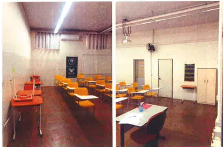
Sala de Formação 01 – Instalação/execução de piso sobre piso existente
