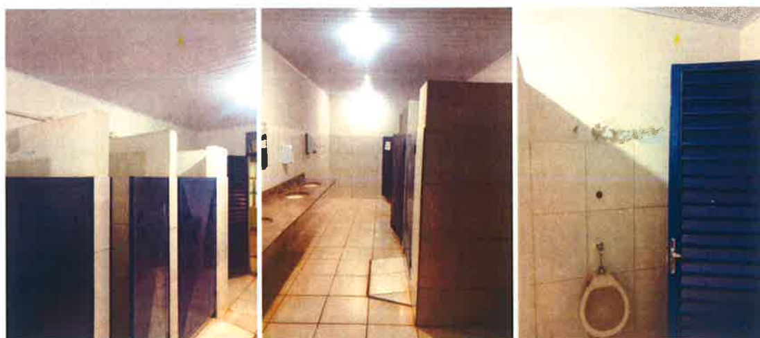
Banho 01 Masculino – Reforma completa com alteração de layout
